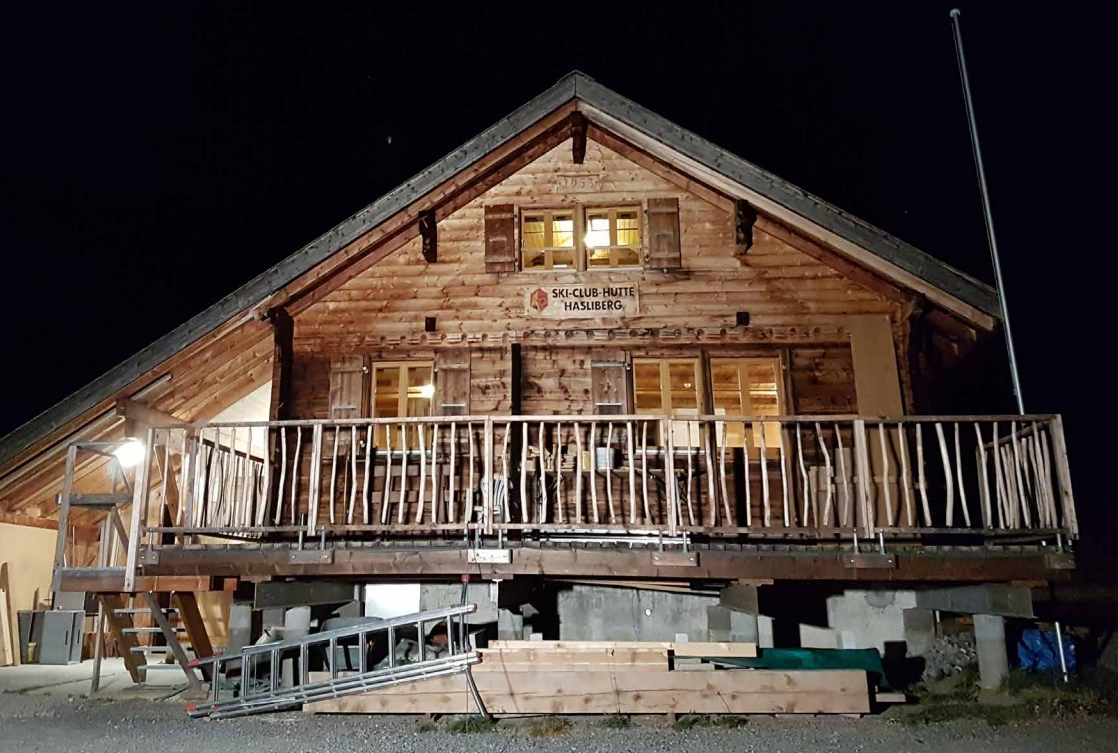
Clubhütte kurz vor Abschluss des Umbaus (20.10.2018)
